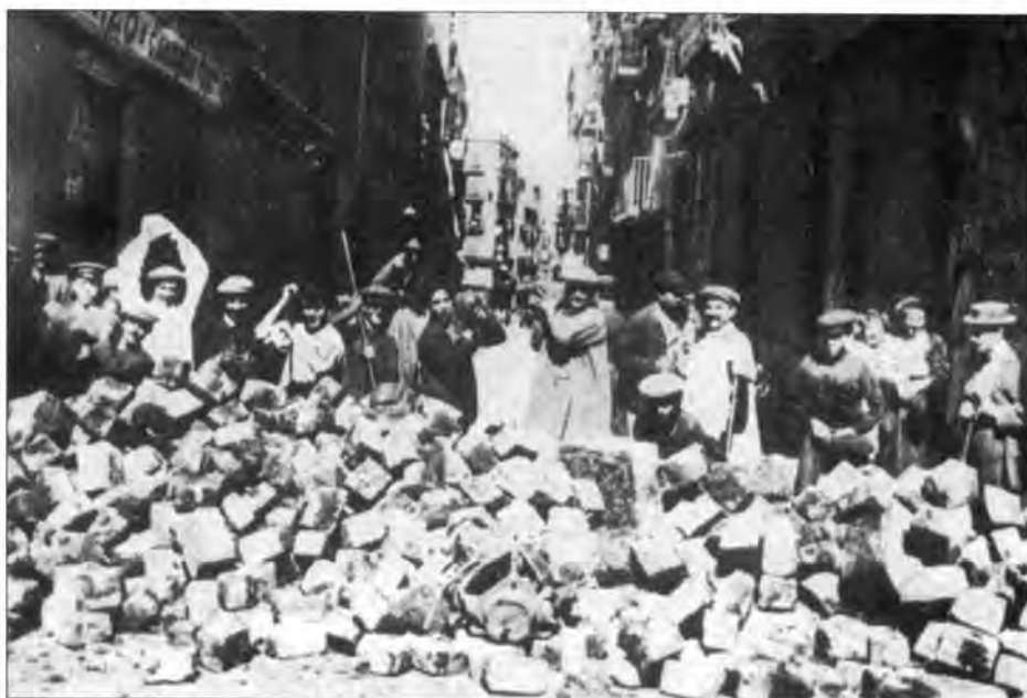
Barricada en la Calle del Hospital
